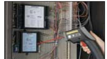
**Paneles de medición difíciles de evaluar con sensores de contacto.**
